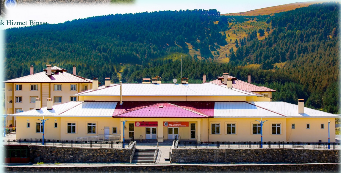
Anaokulu ve Kreş Binası
