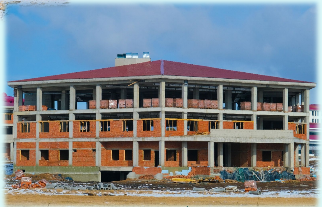
Merkezi Yemekhane Binası İnşaatı
