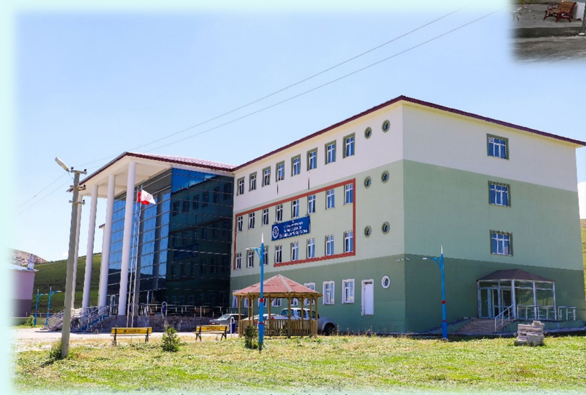
Göle Meslek Yüksekokul Binası
