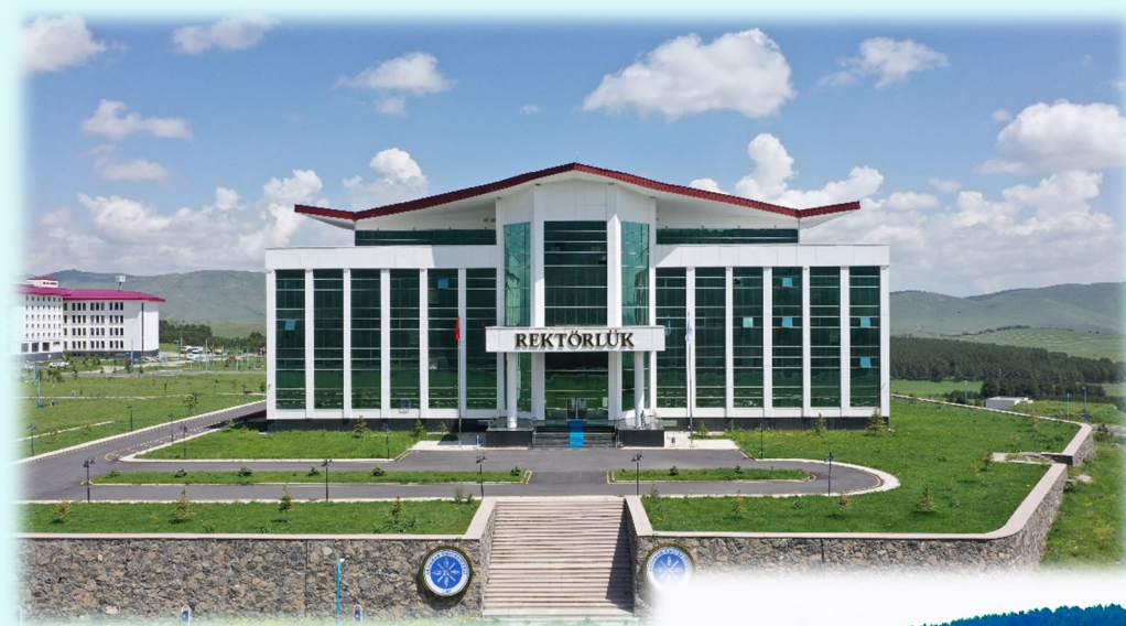
Ardahan Üniversitesi Rektörlük Hizmet Binası
